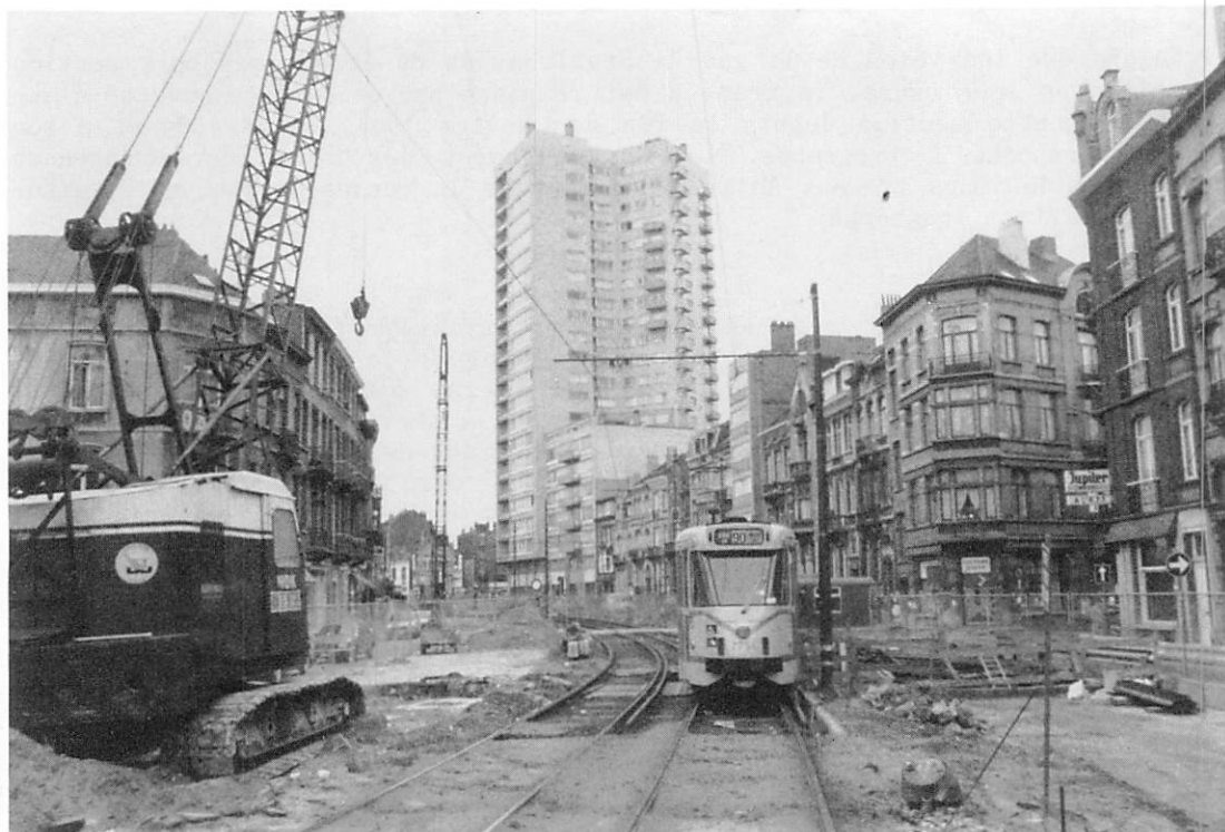
AV. ALBERT (24 novembre 1984). Motrice 7751 - L. 90 traversant le chantier "Albert" du métro bruxellois. (Photo P. Rinert)
